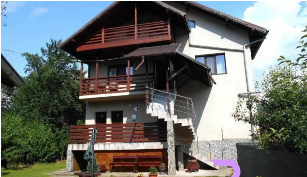
Casa rim exterior
