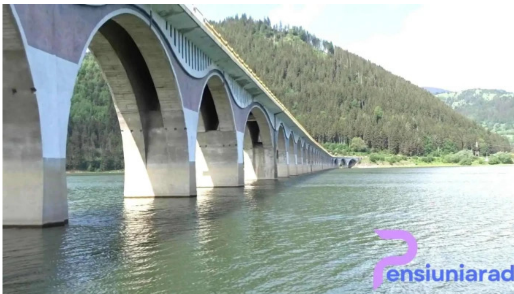
Viaduct poiana teiului munte
