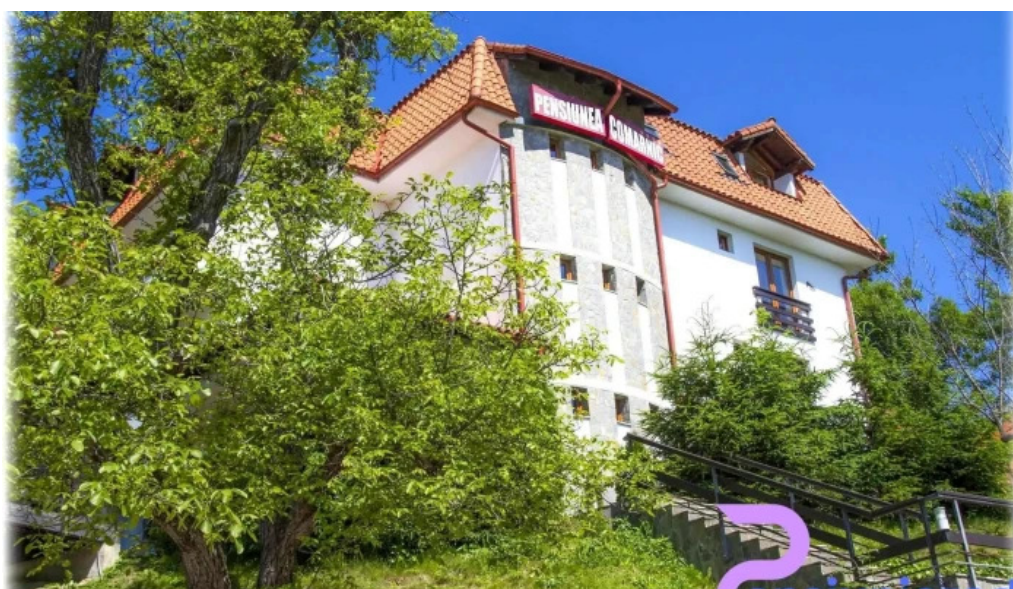
Pensiunea comarnic exterior
