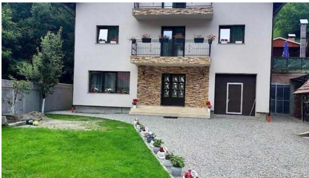
Casa raul brașov
