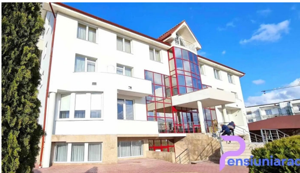
Hotel fan sebes exterior
