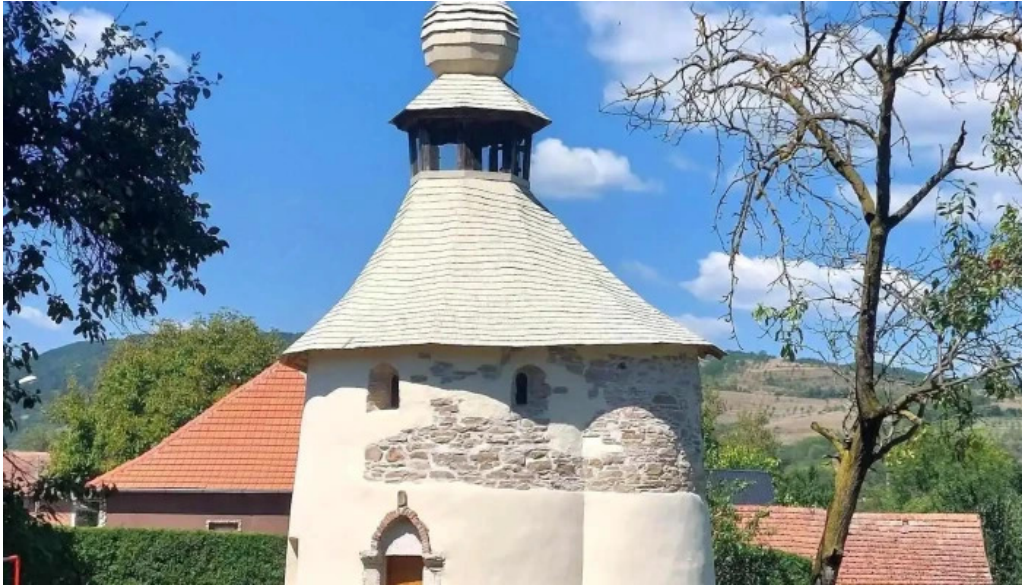
Centrul de tineret geoagiu exterior
