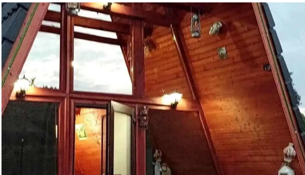
Casuta din zavoii a frame exterior
